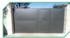
Puerta peatonal encastrada
